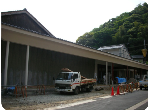
豊岡市は木屋町小路整備事業でホテル跡地に店舗を建設中。ここで実績を積んで商店街に入ってもらおう。
