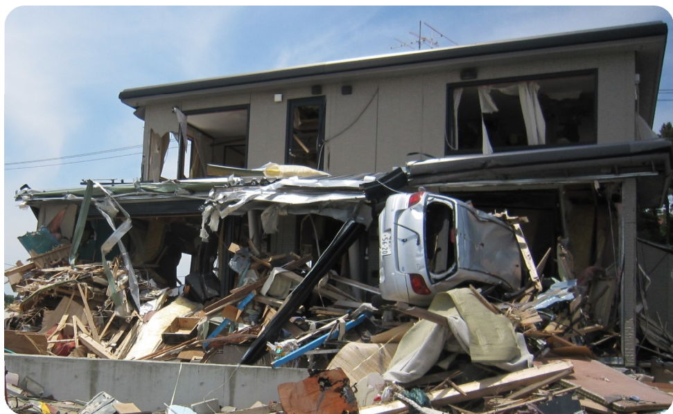
宮城県七ヶ浜町。車が突っ込んだままの家。 2011. 5. 27.
